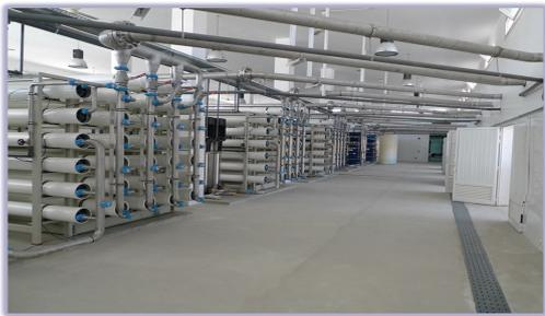
In dem strombetriebenen Verfahren der Elektrolyse kann reines Wasser in seine Elemente Wasserstoff  $H_2$  und Sauerstoff  $O_2$  gespalten werden. Wird dem Prozess Strom aus erneuerbaren Energien zugeführt, entsteht 100 % grüner Wasserstoff. Elektrolyseure dürfen jedoch nur mit extrem reinem Wasser gespeist werden, um Verkalkung und Korrosion im Inneren der Zelle zu vermeiden. Auch Trinkwasser enthält noch zu
